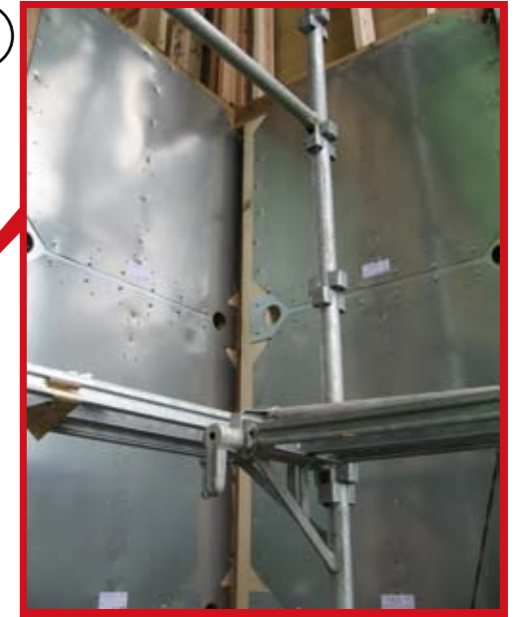
大壁仕様で入隅施工
