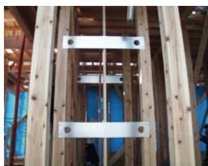
⑤写真右側施工部のSDU-C取付け
