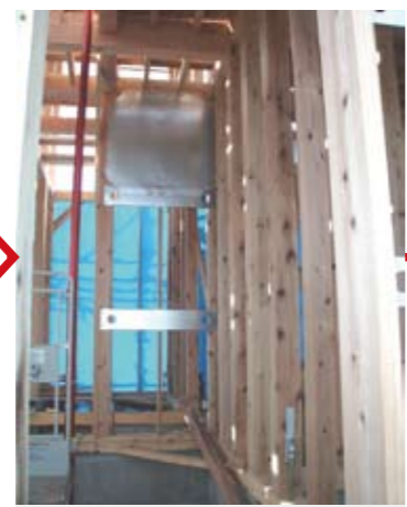
SDU-W取付け中
