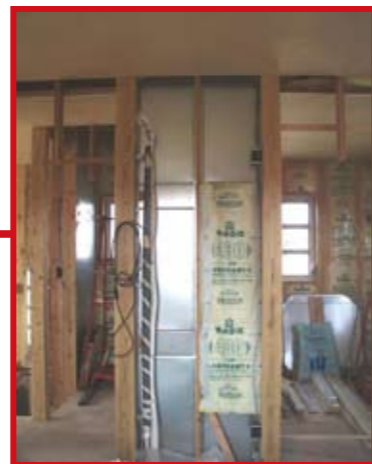
⑧裏側の配線の様子
